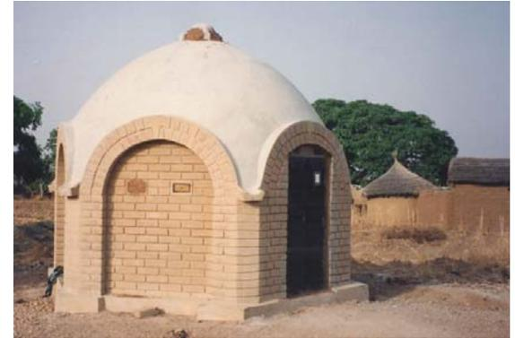
La réalisation d'une coupole comme couverture permet une plus grande étanchéité. La photo reflète une action curative menée avec des comprimés de phosphotoxine. Les bouches d'aération peuvent facilement être colmatées et rouvertes par les paysans.
